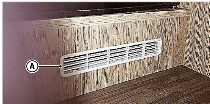
Rys.6.1 - Stałe otwory wentylacyjne
