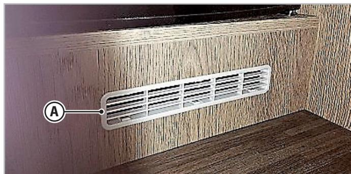
*Fig.6.1 - Aberturas de ventilación permanentes*
